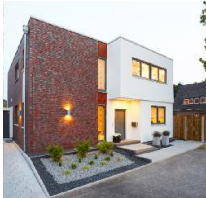
Die Materialkombination an der Fassade verleiht der Architektur hier eine gewisse Spannung.
