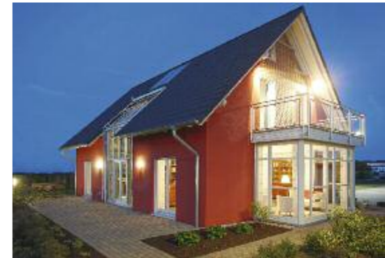
Mit integriertem Wintergarten und verglastem Erker.
