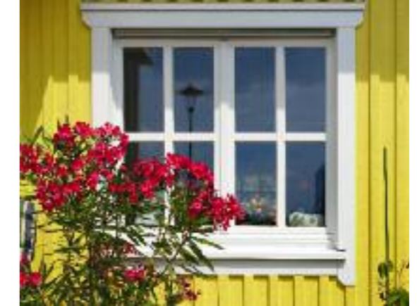
Die Liebe zum Detail zeigt sich auch an den Fenstern.
