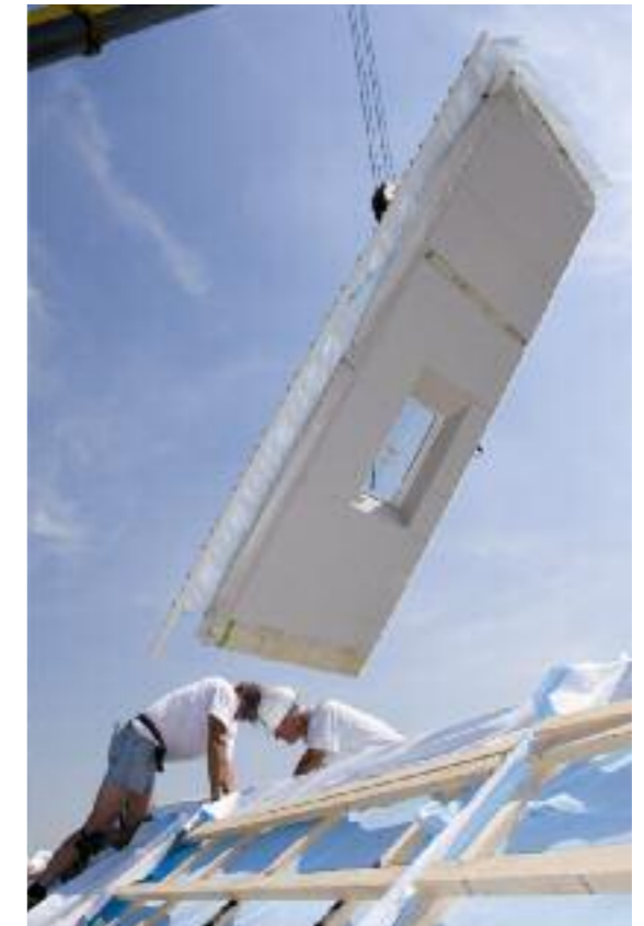
Im Werk vorgefertigte Wand- und Deckenteile sind bereits mit der notwendigen Dämmung ausgestattet, wenn sie auf der Baustelle ankommen.
