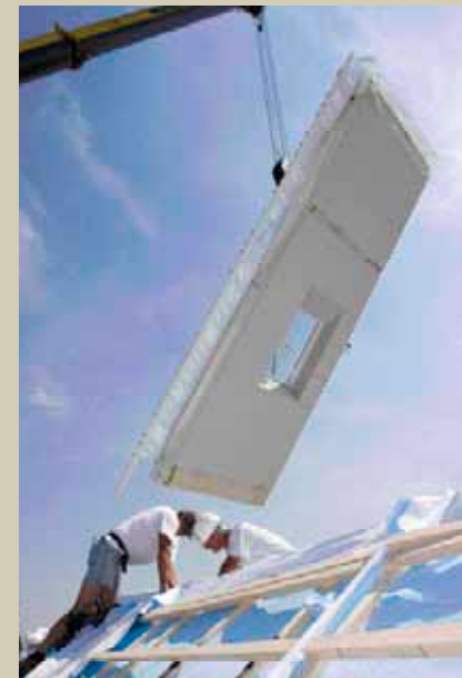
Mit seiner Holzrahmenbauweise setzt der Nordhorner Fertighauspezialist auf ein ökologisches und wohngesundes Material als Herzstück eines jeden GUSSEK-Hauses. Die einzelnen Elemente der Entwürfe werden dabei trocken und sicher im Werk vorgefertigt und erst auf der Baustelle montiert. So hat Feuchtigkeit in den Bauteilen des neuen Eigenheims von vornherein keine Chance.
