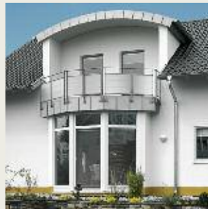
Trauferker, einschalige Putzfassade
