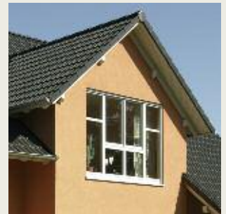
Trauferker, zweischalige Fassade
