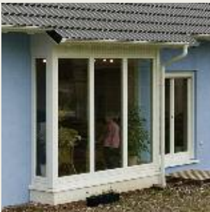
Trauferker als Blendrahmenkonstruktion
