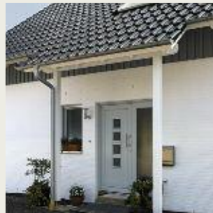
Vordach als Dachschleppung
