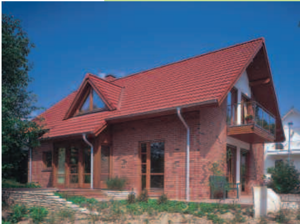
Gussek Haus kann auf über 55 Jahre Erfahrung im Hausbau zurückblicken. Typisches Markenzeichen für Gussek-Fertighäuser ist die zweischalige Wandkonstruktion, bei der vor die Holzrahmenkonstruktion noch eine Schicht aus Klinker- oder Dämmsteinen gesetzt wird – eine Besonderheit in der Fertighausbranche.
