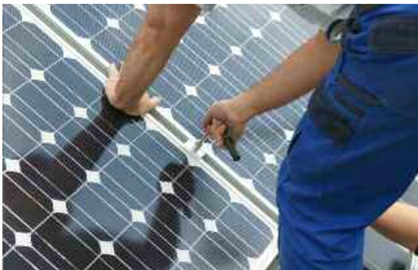
Monokristalline Solarzellen zeichnen sich durch einen besonders hohen Wirkungsgrad aus.
