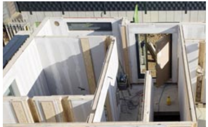
Innerhalb weniger Stunden werden auf diese Weise komplette Stockwerke zusammengebaut.
