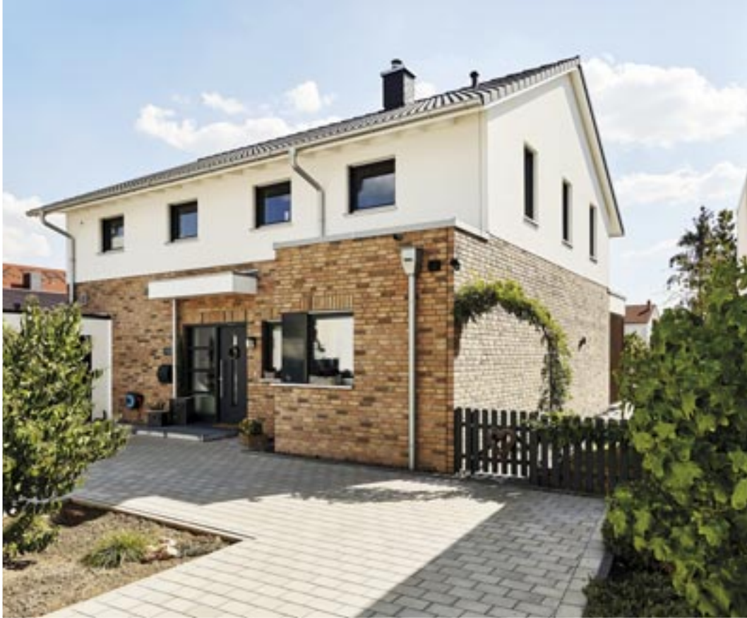
Apartment kombiniert: die massiv vorgemauerte Mixfassade aus Klinkern und Putz. Vom Schreibtisch im Erker aus hat der Hausherr immer im Blick, wer kommt.
