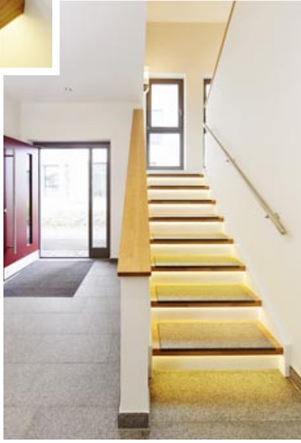
Diese raffiniert ausgeleuchtete Treppe mit Graniteinlegern in den Eiche-Trittstufen verbindet Sicherheit mit Langlebigkeit.
