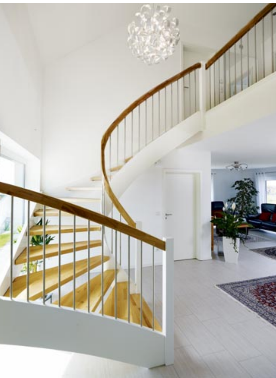
Elegant geschwungen nach oben: halb gewendelte Treppe mit in die Wangen eingestemten Stufen.
