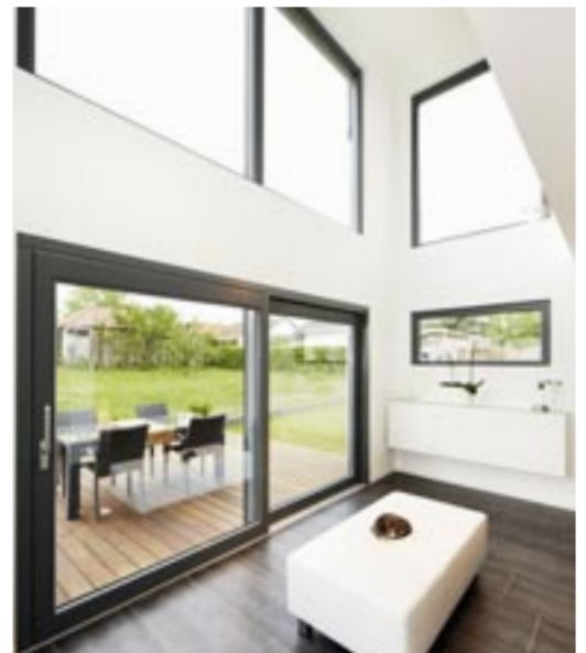
Moderne Hebe-Schiebetüren ermöglichen den fast schwellenlosen Übergang nach draußen.
