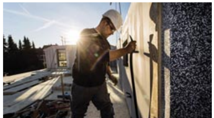
Wenn das Dach gedeckt ist, beginnt alsbald der Innenausbau, und die Tage bis zum Einzug lassen sich zählen.
