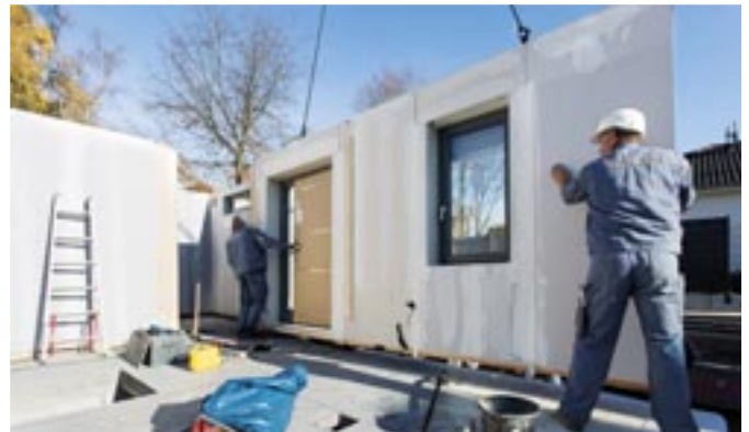
Millimeterarbeit: Die Wände werden an den vorher markierten Positionen ausgerichtet und verankert.
