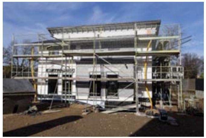
Das Dach ist spätestens am zweiten Tag des Aufbaus komplett gedeckt.
