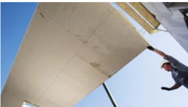
Die Geschosdecken und das Dach werden in Groelementen vorgefertigt und mit Hilfe des Krans aufgelegt und montiert.
