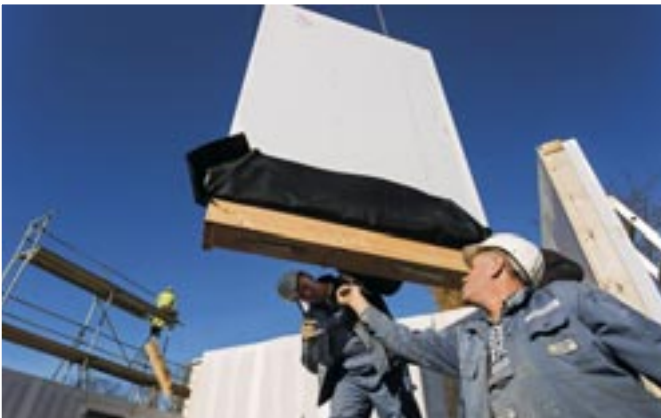
Die perfekt maßgenaue Vorfertigung im Werk garantiert eine schnelle und reibungslose Montage auf der Baustelle.
